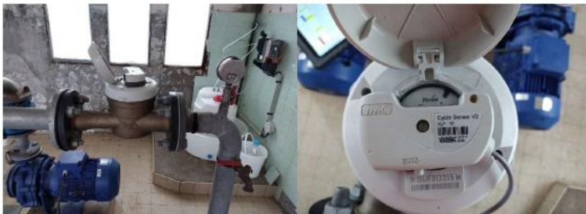
Figure 1 Compteur équipé d'une tête émettrice
