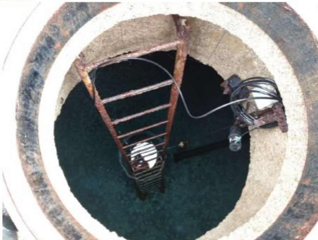
Figure 3 Sonde piézométrique immergée dans un réservoir
