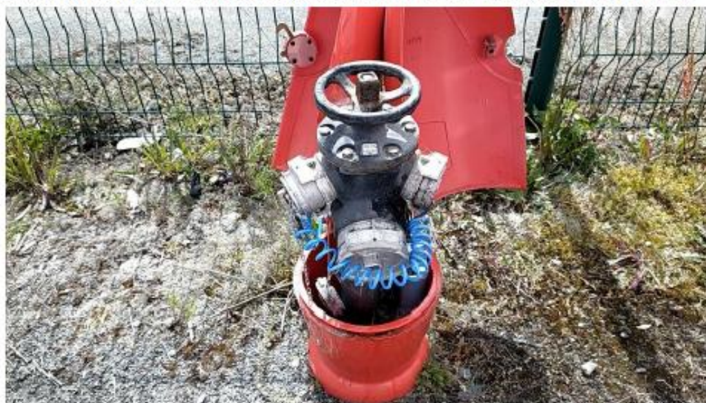
Figure 2 Poteau incendie équipé d'un capteur de pression
